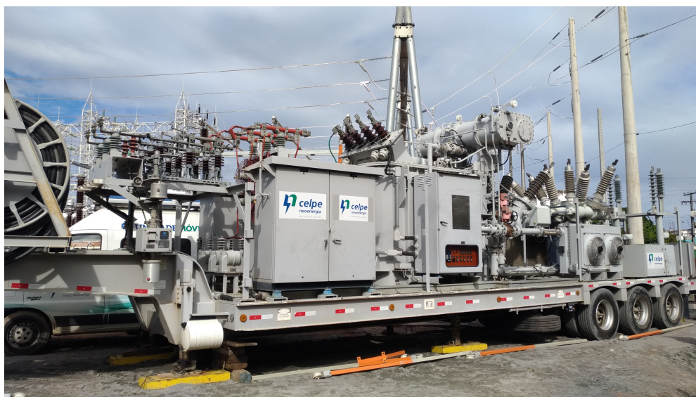
Figura 14 – Tranformador móvel.
