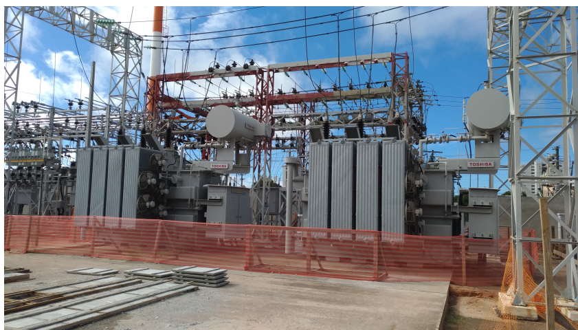
Figura 13 – TC's e TP's da seção 13,8kV.
