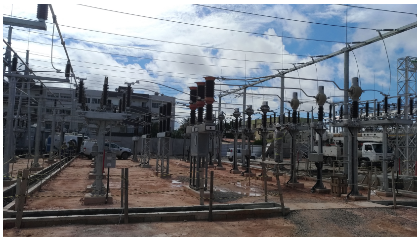
Figura 11 – Chaves seccionadoras.
