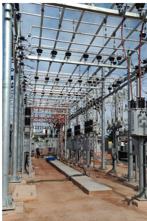
Figura 13 – TC's e TP's da seção 13,8kV.
