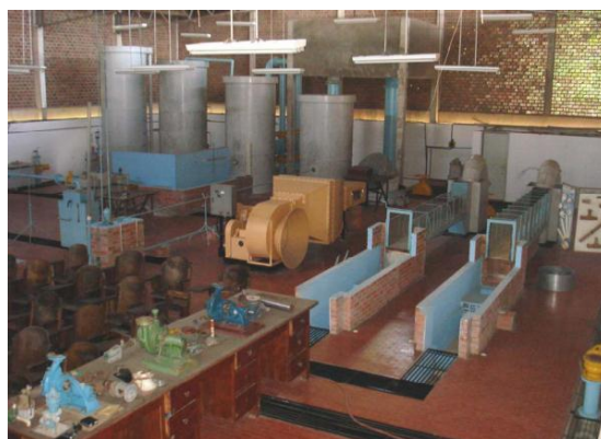
FIGURA 1 – LABORATÓRIO DE EFICIÊNCIA ENERGÉTICA E HIDRÁULICA EM SANEAMENTO.
