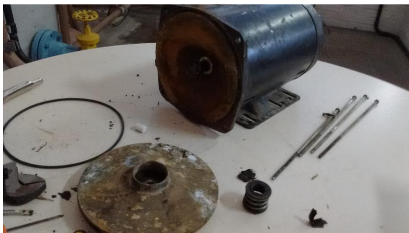
FIGURA 17 – CONJUNTO MOTOBOMBA 2 DESMONTADO.
