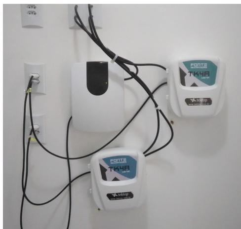
Figura 28: Fontes de alimentação da Fechadura *Knox*
