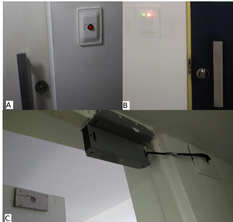
Figura 29: A: Botão para destravar a porta pelo lado interno. (B): leitor RFID acesso pelo lado externo. (C): Eletroímã
