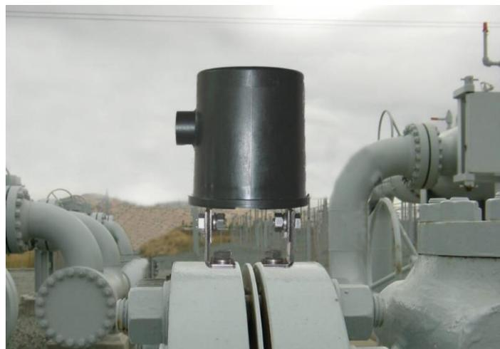
Figura 11 – Proteção de junta isolante.
