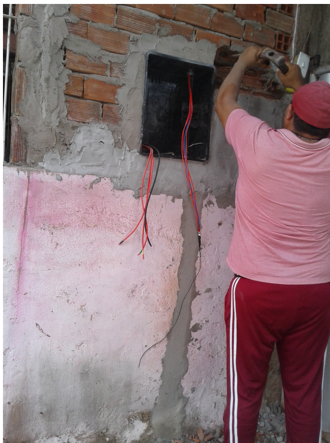
Figura 25: Técnico de instalação realizando ajustes na estrutura física para instalação do medidor bidirecional.
