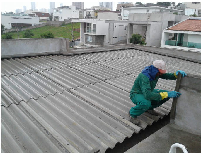
Figura 18: Imagem 1 do telhado de um cliente durante a visita técnica.
