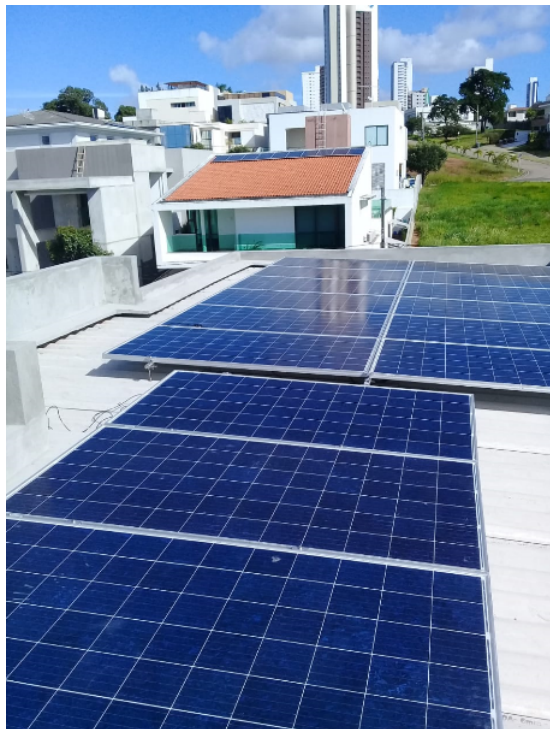
Figura 21: Instalação do sistema fotovoltaico do cliente.
