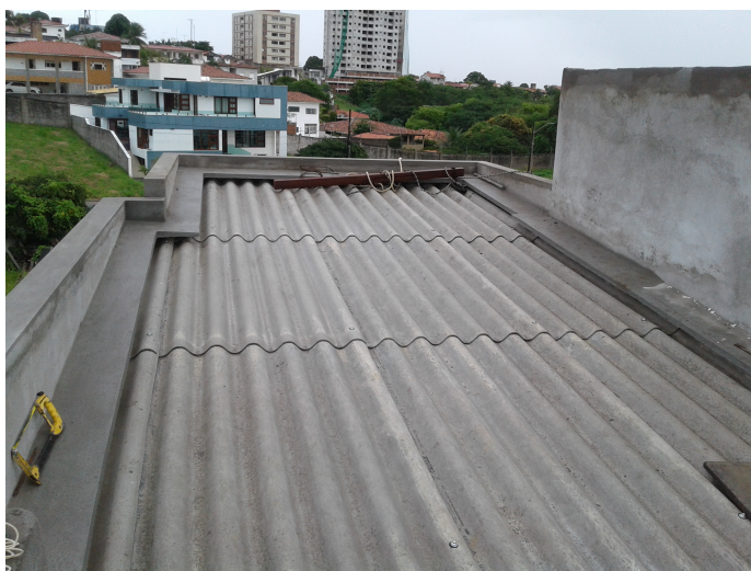
Figura 19: Imagem 2 do telhado de um cliente durante a visita técnica.
