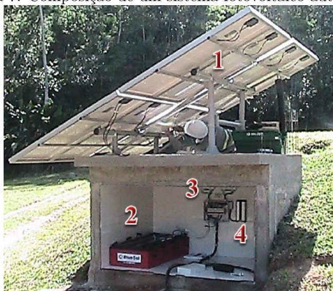
Figura 7: Composição de um sistema fotovoltaico autônomo.
