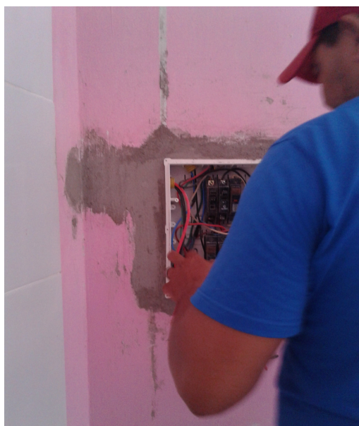
Figura 22: Técnico de instalação manuseando o quadro de distribuição da residência.
