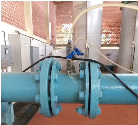
Figura 1 – Placa de orifício do LENHS
