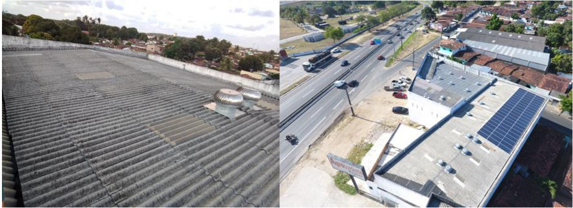
Figura 9-Vista aérea do SFCR da Via Campo Rações e Medicamentos Veterinários
