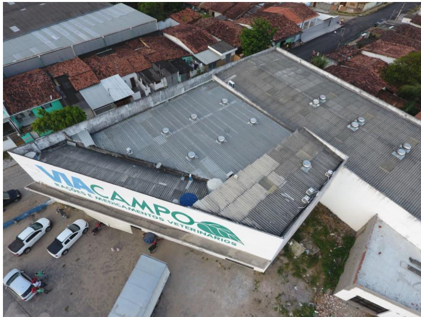
Figura 8-Vista Aérea de um telhado capturado pelo drone da empresa
