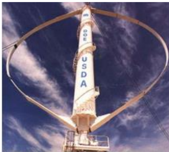
Figura 6- Aerogerador de eixo vertical [18].
