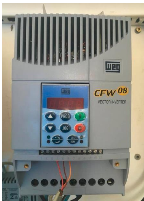
Figura 3.3- Inversor de Frequência CFW-08
