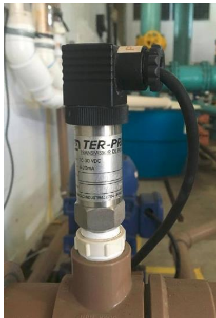
Figura 3.4- Transdutores de pressão da Acros.
