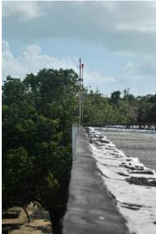
Figura 5.1: Captor em local de difícil acesso
