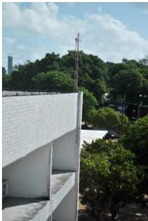
Figura 5.2: Captor em local de difícil acesso
