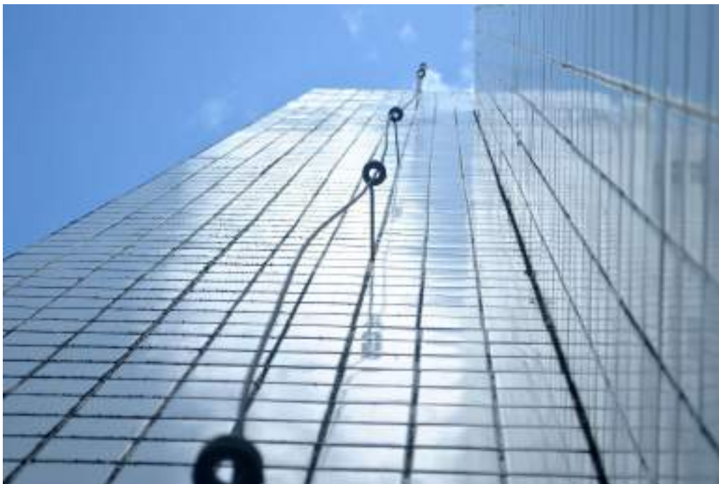
Figura 5.5: Descidas Retas e verticais e parede de cerâmica
