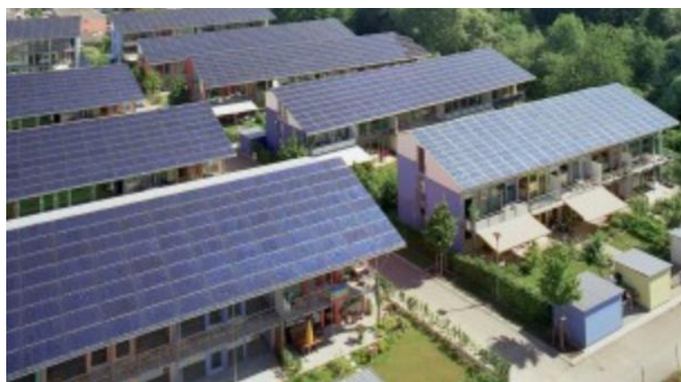
Figura 21 - Sistema BIPV de cobertura.
