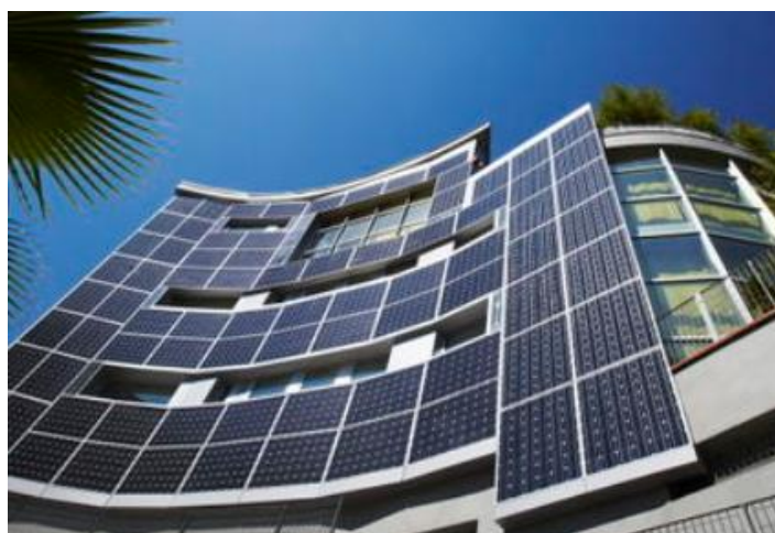
Figura 19 - Fachada de edifício coberta por painéis solares.
