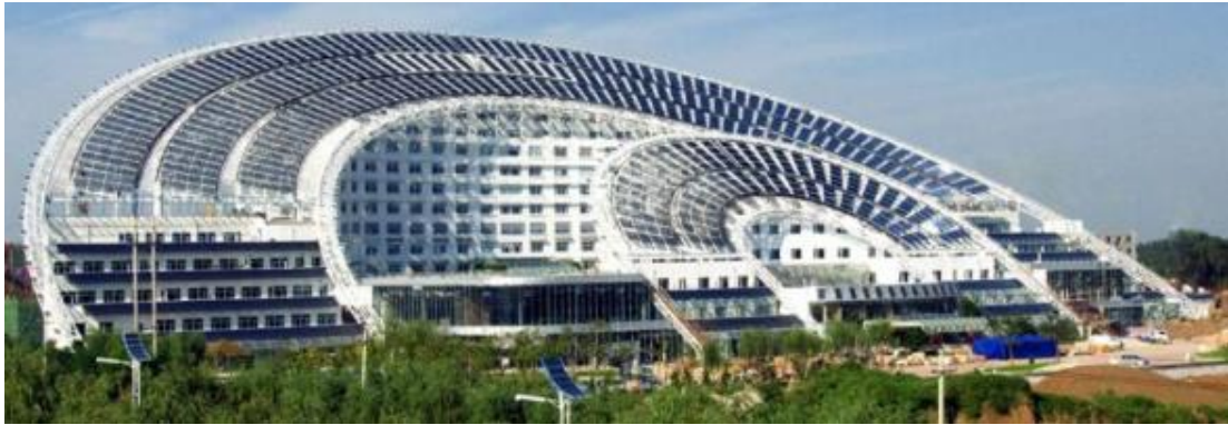
Figura 23 – Imagem do Solar Powered Office Complex [13].
