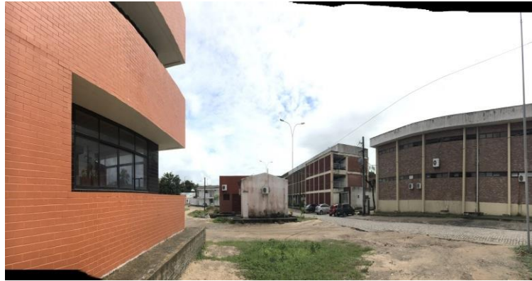
9a - Acabamento da fachada Sudeste: revestimento cerâmico na cor terracota 5cm x 10cm
