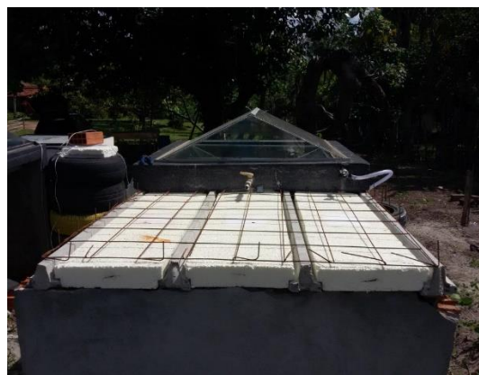
Figura 34 -Isolamento térmico com placas EPS (Isopor)
