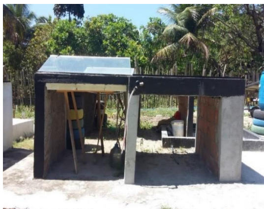
Figura 33 - Lateral oeste da estrutura.
