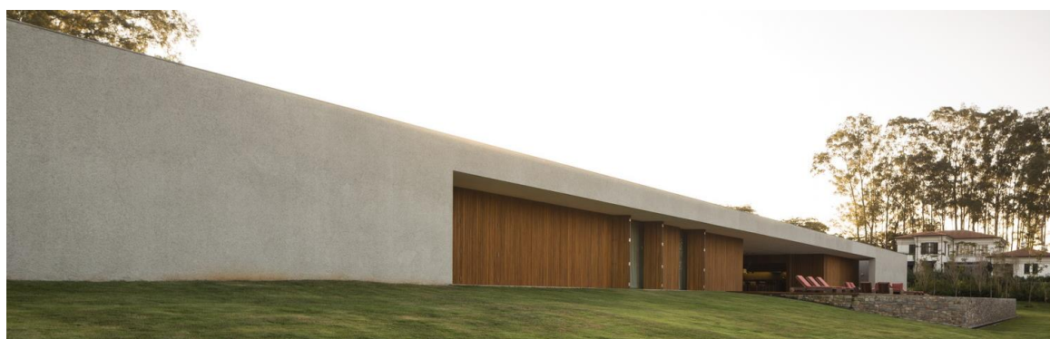
Figura 15. Fachada leste com parte dos muxarabis abertos.
