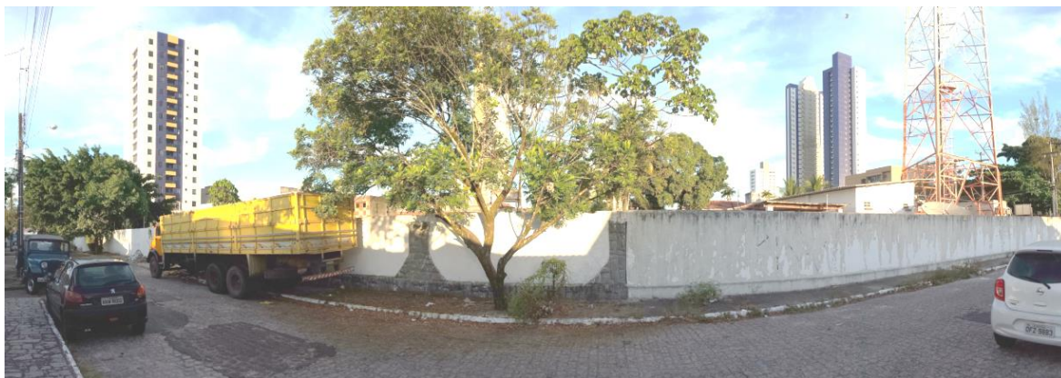
Figura 22. Panorâmica da rua do terreno em estudo.
