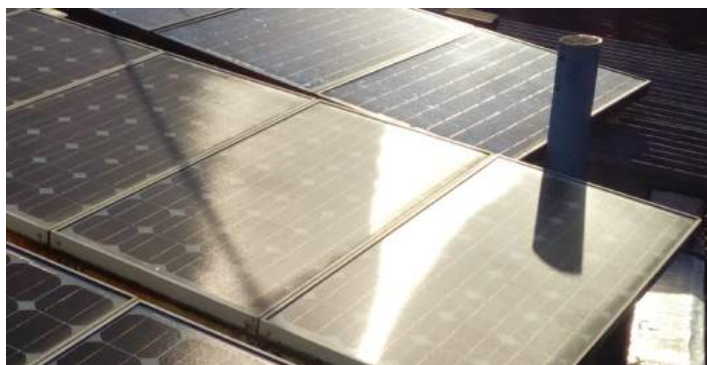
Figura 87. Sombreamento sobre o arranjo de módulos fotovoltaicos que aparece depois das 15:30 horas. O sombreamento reduz a corrente de saída do sistema. Fonte: Autoria própria.
