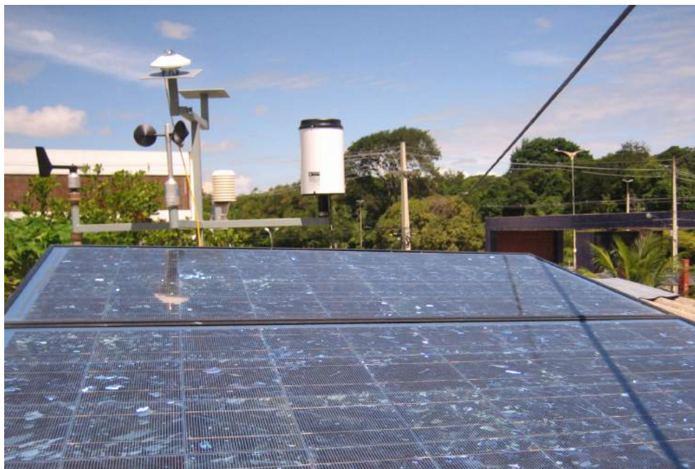
Figura 67. Datalogger Ammonitor® Meteo-40 instalado para controlar as medições de alguns instrumentos climatológicos. Fonte: Autorialia propia.
