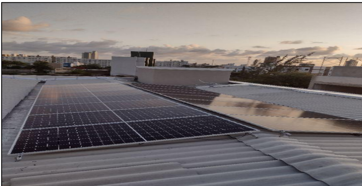
Figura 3.2 - Configuração do sistema fotovoltaico analisado, com módulos inclinados a 10^\circ e orientados nas direções oeste e leste na cidade de João Pessoa – PB.
